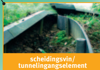
tunnel in verkeersdrempel
