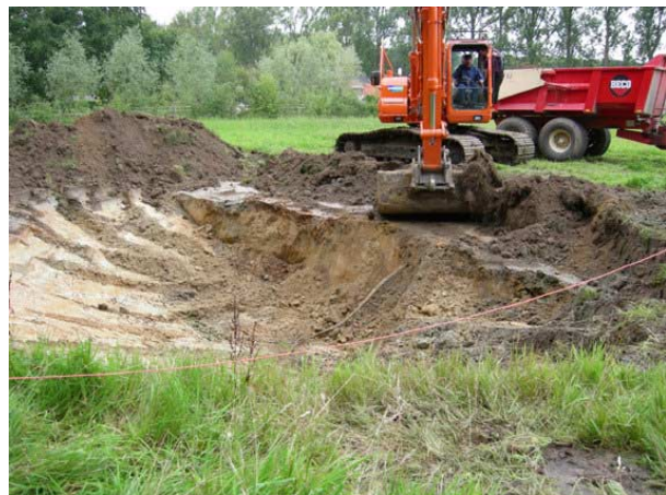
Fig. 1. Aanleg van een nieuwe poel in de Bosstraat te Merelbeke (Munte), augustus 2006.
