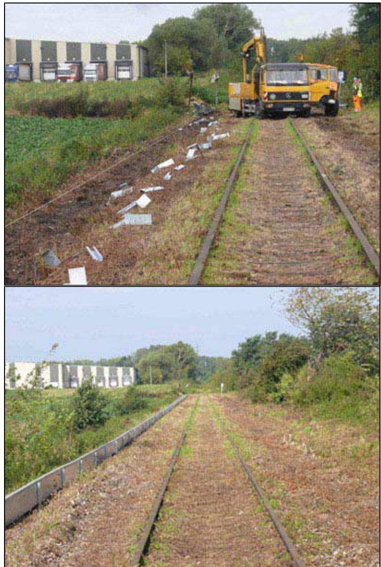
Fig. 2 . Plaatsen en afwerken van de schermen langs het spoor (foto Alex Kloor)
