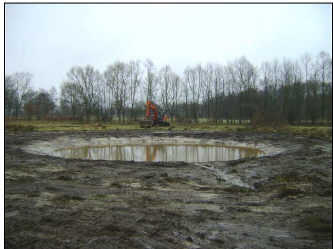
Fig. 2. Poel 29 is bijna een feit. Op de achtergrond de bestaande houtwal die in maart zal verder worden aangeplant met struiken om een buffer te vormen tegen negatieve invloeden van bemesting en chemische bestrijdingsmiddelen in het aangrenzend akkerland. Deze houtwal zal tevens als leefgebied moeten dienen voor amfibieën. De poel halveert de afstand tussen twee voortplantingspoelen van boomkikker en kamsalamander naar slechts 300 meter en vormt een stapsteen tussen het kerngebied en de oostelijke metapopulatie.
